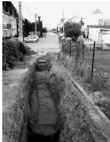
Výkop kanalizace na Požární
