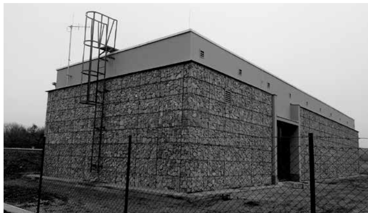
Úpravna vody Zaječí nový vodojem
