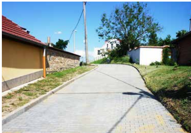
Opravená ulice Domky
