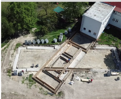
Pohled na stavbu shora. V květnu 2023 už byly vidět základy a půdorys zajímavě řešené přístavby.
