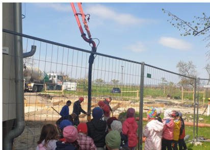
Postup stavby bedlivě sledují i děti, které chodí do stávající budovy mateřské školy. Ta má od roku 2012 kapacitu stanovenou na 61 dětí, z toho 50 na celodenní a 11 na polodenní docházku.
